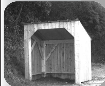
Abri-bus de Saint-Lubin
